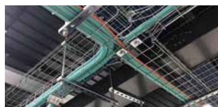
中国建设银行安徽分行 中心机房
